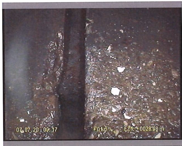
Figura 4: Giunto da sigillare
