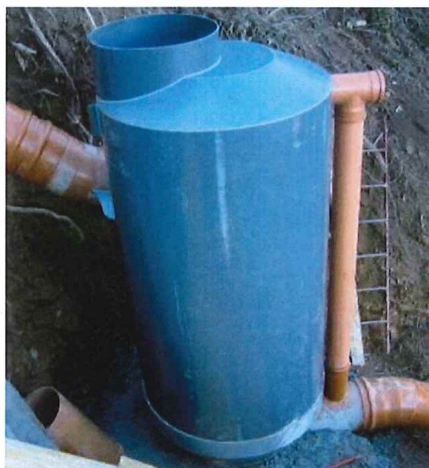
Figura 13: Esempio di pozzetto-camera di rottura modello Canplast®
